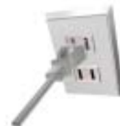
仮設電源工事
